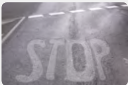
Fresado sobre asfalto
