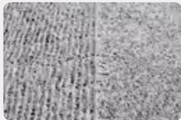
Fresado sobre hormigón
