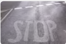
Fresado sobre asfalto
