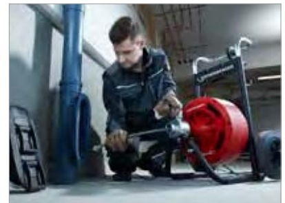
Limpeza de una tubería bajante con espiral de 16 mm
