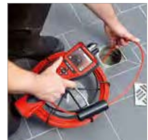
Inspección de sumideros
