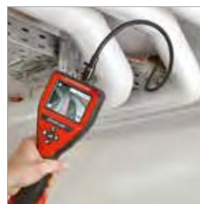
Inspección de espacios huecos
