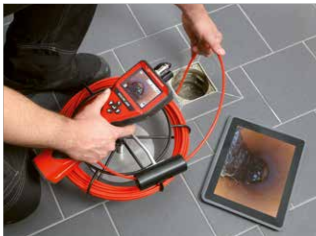
Inspección de drenajes de baños
