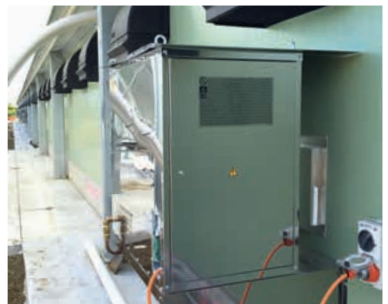
instalación en el exterior
