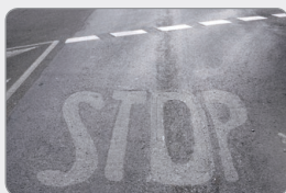
Fresado sobre asfalto
