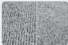
Fresado sobre hormigón
