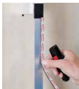
Paso 3: Colocar la cinta Foam Tape
