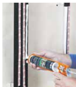
Paso 4: Aplicar el adhesivo
